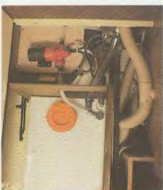
Wintertaugliche Verlegung der Wasserver- und -entsorgung.
